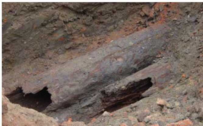
Fot. 8. Fragment XVII-wiecznego wodociągu zachowanego pod powierzchnią ulicy od strony wschodniej Placu Orła Białego, 2015 rok
