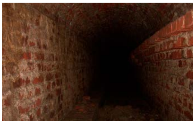
Fot. 10. Tunel biegnący pod Placem Orła Białego. Widok w kierunku północno-wschodnim, 2015 rok
