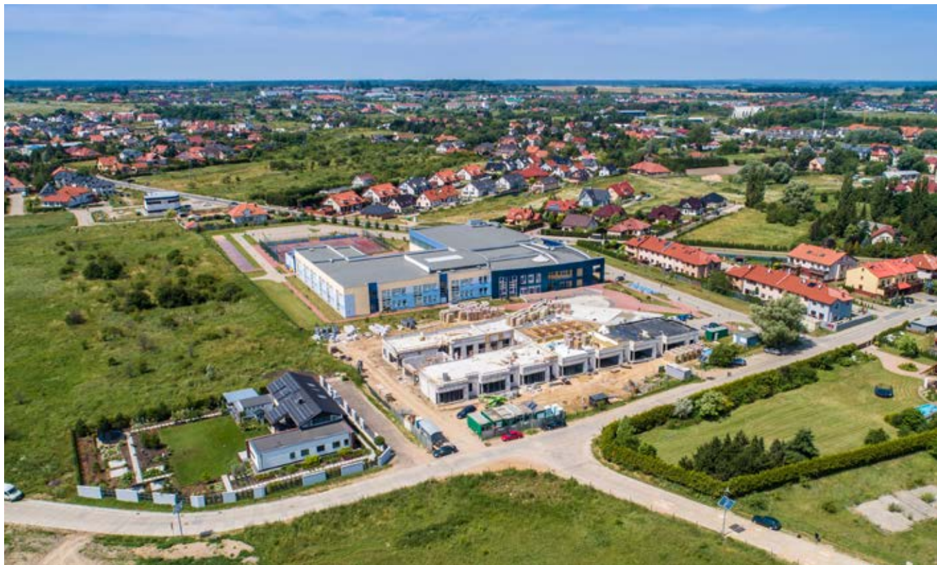
Fot. 1. Budowa przedszkola publicznego w Mierzynie
