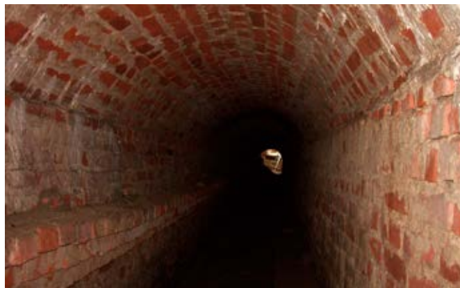
Fot. 9. Tunel biegnący pod Placem Orła Białego. Widok w kierunku południowo-zachodnim, 2015 rok
